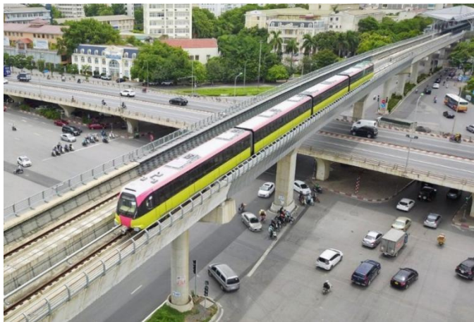
Рис. 2. Эстакадный участок линии метрополитена Ханоя (линия 3)
